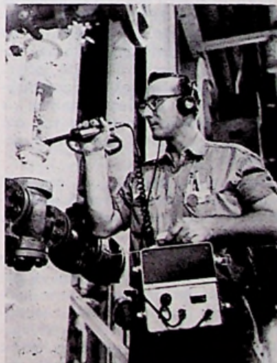
Met behulp van de microfoon-opnemer wordt een pakking van een regelklepbuis in een 15 atm stroomdruk-systeem afgeluisterd. Een zeer klein lek is reeds op enige afstand te constateren.
